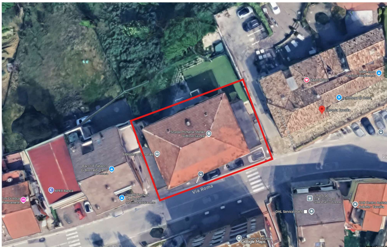
Figura 1: VISTA AEREA DEL FABBRICATO
